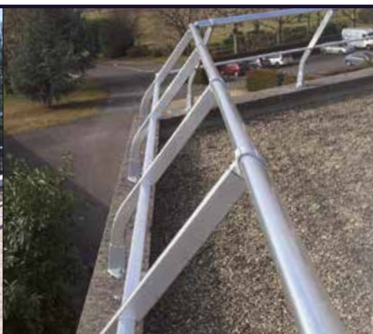
Garde-corps incliné VECTACO® fixation à plat sur acrotère
