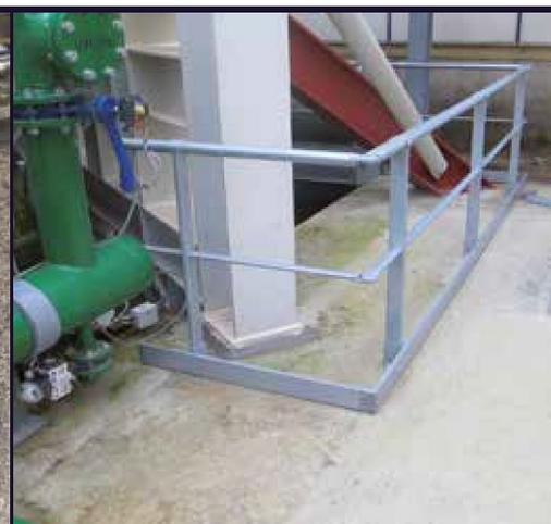
Garde-corps avec plinthe VECTACO® fixation à plat
